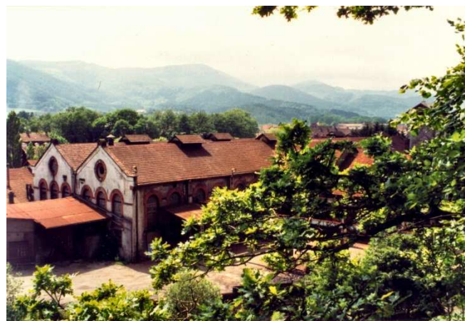
La fonderie de Masevaux en 1994 avant sa démolition
